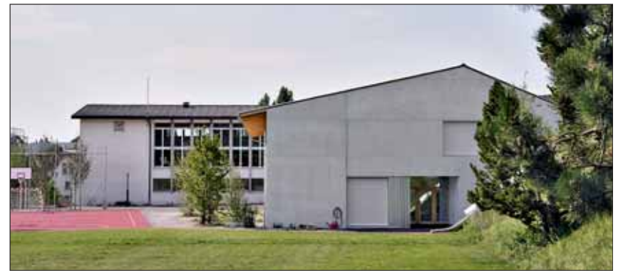
Das neue Schulhaus im schweizerischen Birrwil – im Blick die Nordfassade und der Eingang des Kindergartens. Die Fassade besteht aus Sichtbeton.
