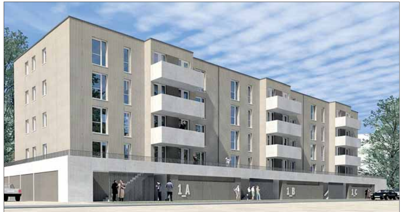
In der Wagenfeldstraße in Hamburg sollen rund 35 geförderte Wohneinheiten entstehen. Das Gebäude ist als Parkplatzüberbauung geplant. Aufwendige und teure Lastdurchführungen werden in diesem Projekt durch die Anordnung der Wohnungswände über den Wänden der Parkebene vermieden. Grafik: KG Architekten, Hamburg
