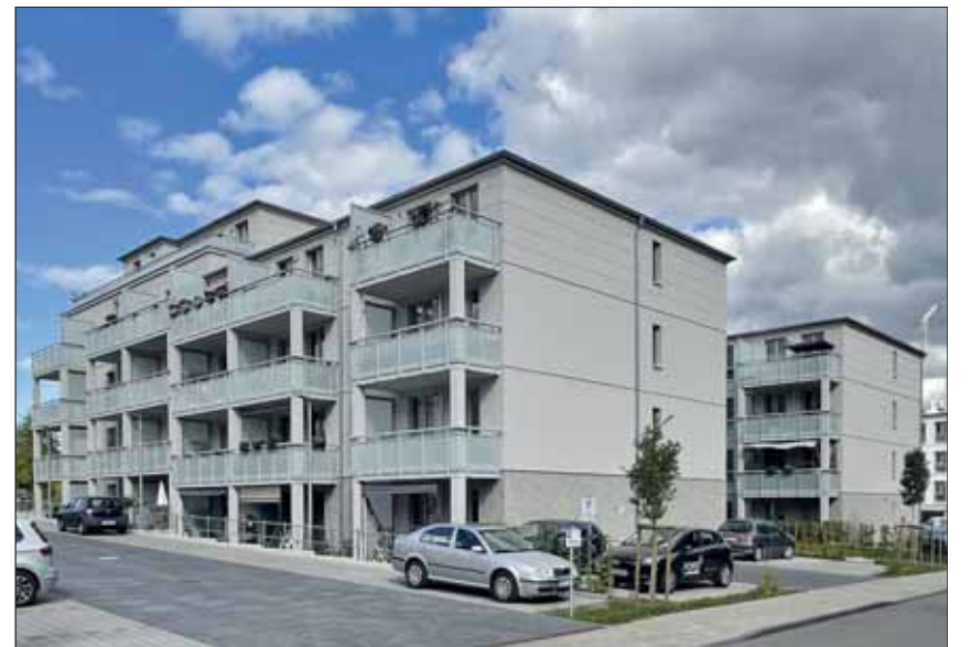
In der Wittinger Straße in Celle entstanden 90 geförderte Wohnungen. Die Strom- bzw. Wärmeversorgung erfolgt durch Photovoltaik und Geothermie. Fotos (2): B&O Bau Hamburg GmbH
