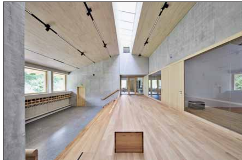
Im Inneren kamen Sichtbeton und akustische Wandverkleidungen mit Furnieroberfläche zum Einsatz (Eiche und Weißtanne). Für den Boden wurde Eichen-Parkett verwendet. Fotos: Basile Bornand, Basel
